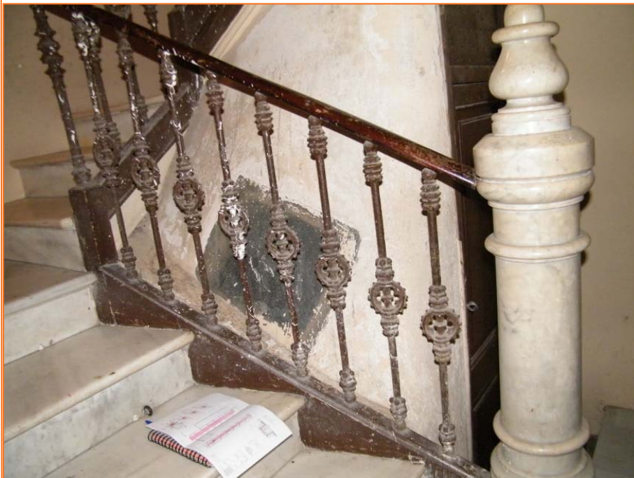
Foto 2. Vista inicial de l'emplaçament de l'ascensor.
