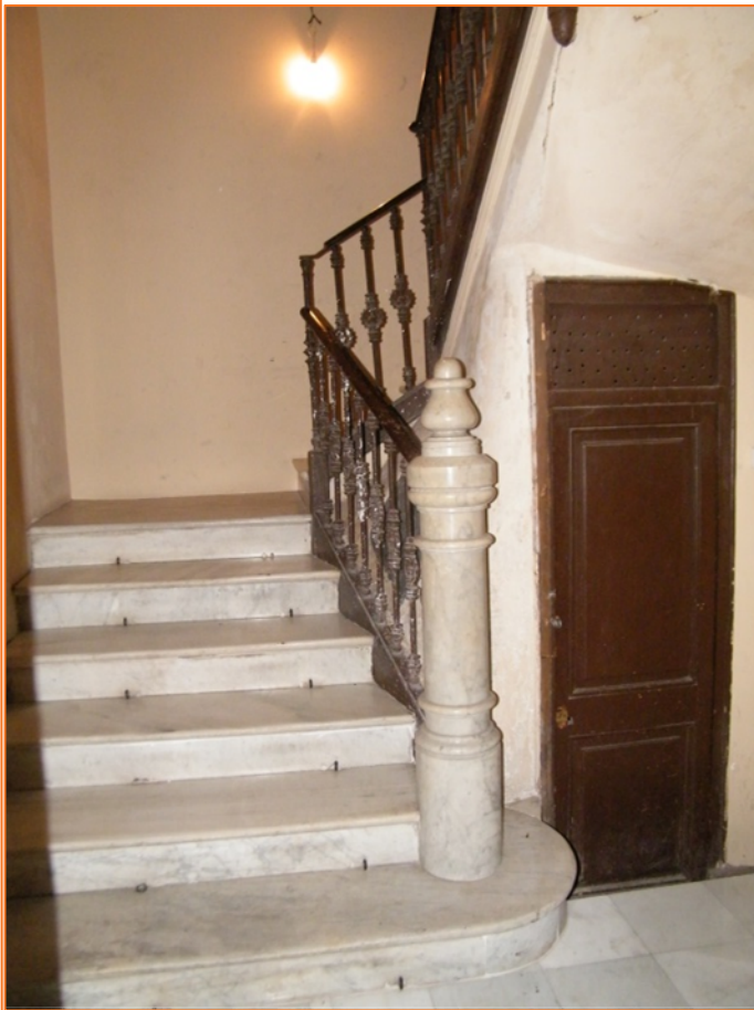
Foto 1. Vista inicial de l'emplaçament de l'ascensor.
